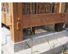
[左] 写真奥が伝統構法で新築した住宅。左手前は改修予定の土蔵 [上] 礎石の上に柱を立てる「石場建て」を採用
