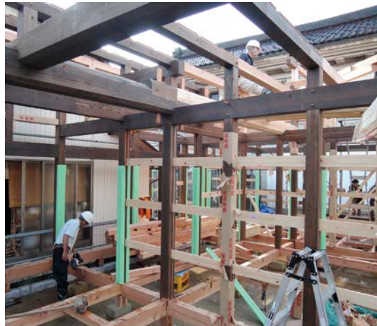
施工時の様子。柱に貫を通す貫工法で構造をつくった
